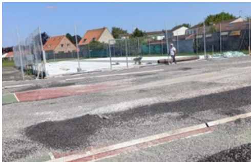
Réfection des terrains de tennis (toujours en cours)
